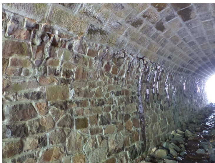
Foto č. 3 K 01 Průsaku vody a výluhy pojiva nad opěrou O 02
