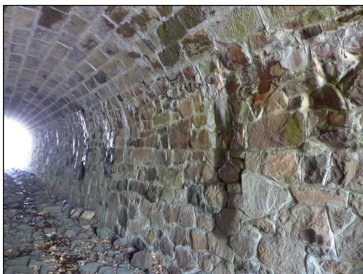
Foto č. 2 K 01 Průsaku vody a výluhy pojiva nad opěrou O 01 vlevo
